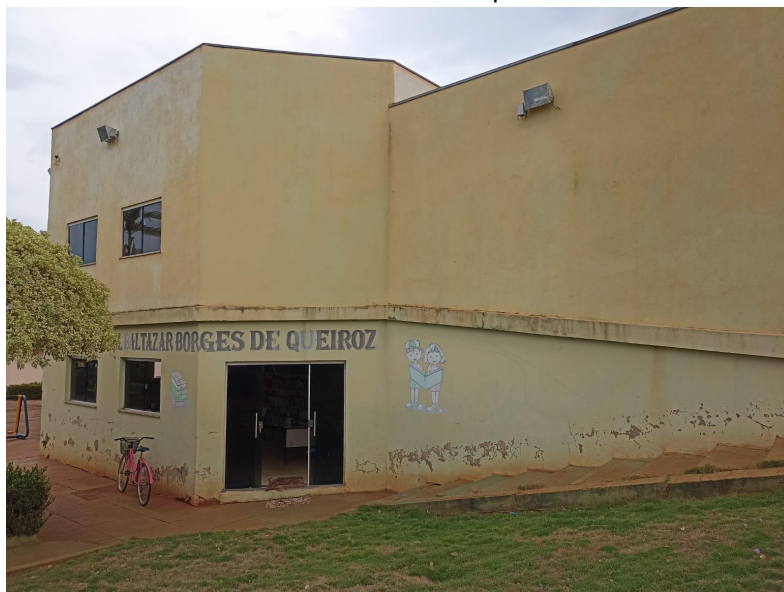
Foto 01 - Fachada de entrada da Biblioteca Municipal de São Francisco de Sales/MG
