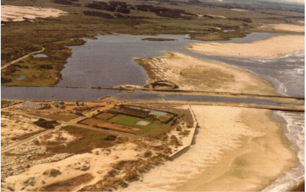
Figura 34 - Obra dos Molhes do Mampituba Fonte: Acervo do Museu Três Torres -SAPT, 2015
