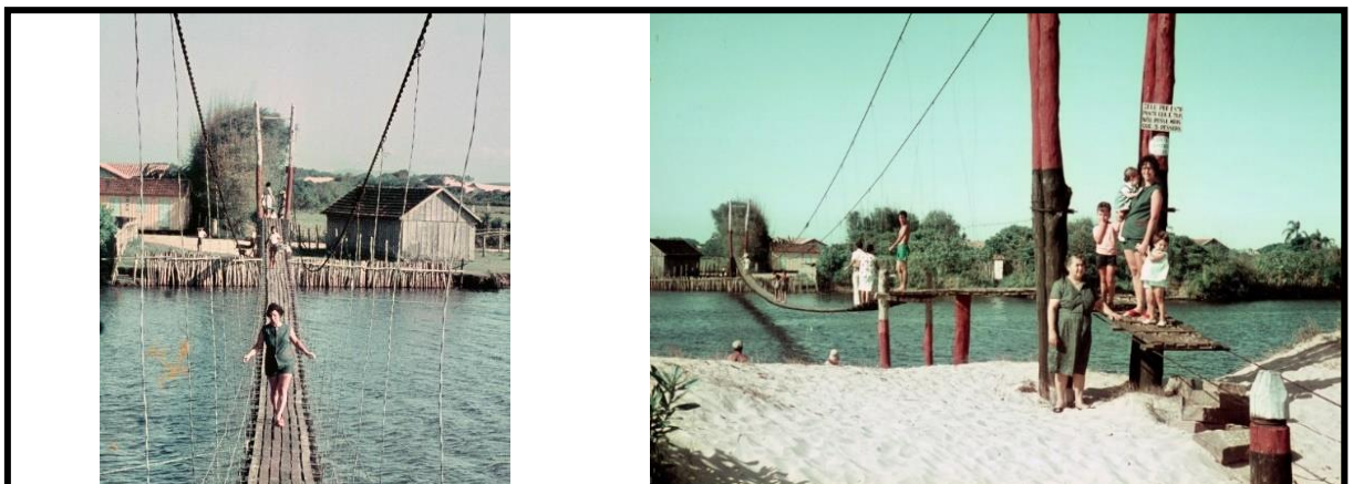
Figura 15 - Ponte Pênsil no ano de 1965 Fonte: Fotos do acervo de Paulo Fernando Gobbato, 2021
