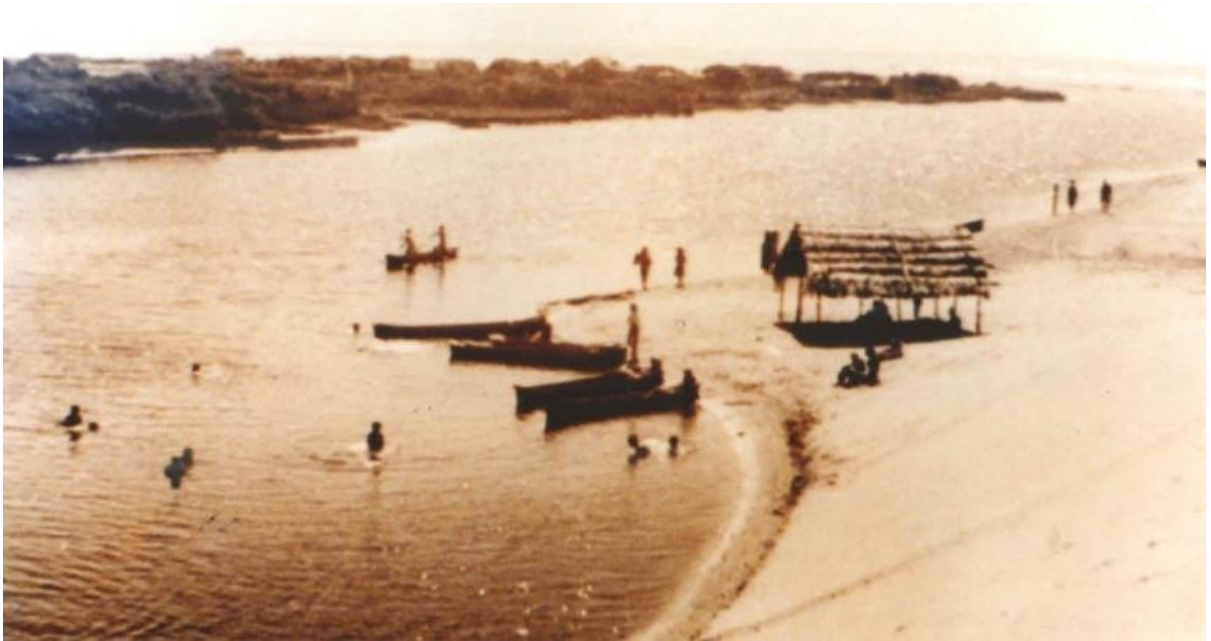
Figura 16 - Local da ponte pênsil antes da construção Fonte: Acervo Venturella Museu Histórico de Torres
