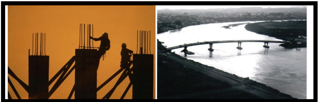
Figura 32 – Fotos da ponte em construção, 2006 Fonte: Acervo Departamento de Cultura da SMEC, 2014
