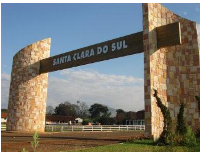
Pórtico de Entrada do Município.
